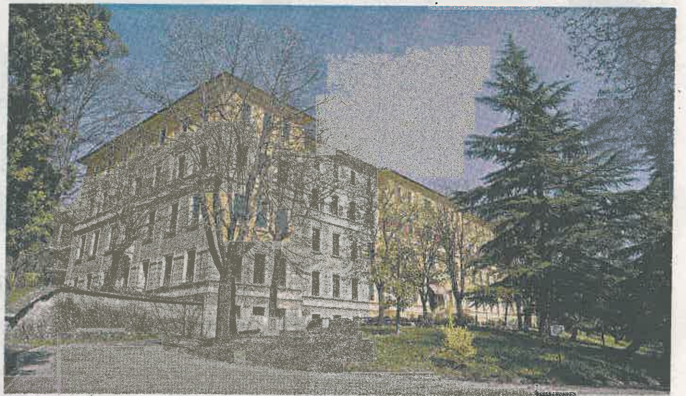
Hotel Valentini Insieme al Porro è uno dei due alberghi di proprietà delle Terme di Salsomaggiore.
