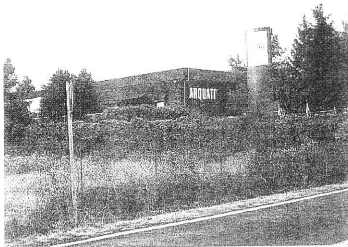
Lo stabilimento Arquati
