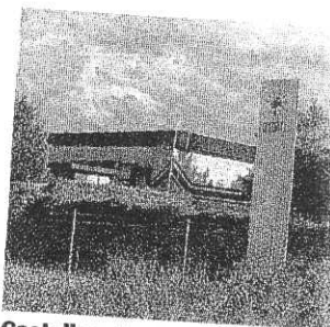
Castellaro La sede dell'Arquat
